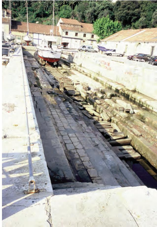
*Il bacino di carenaggio dell'Arsenale di Villafranca oggi utilizzato per la riparazione e manutenzione di yachts.*
