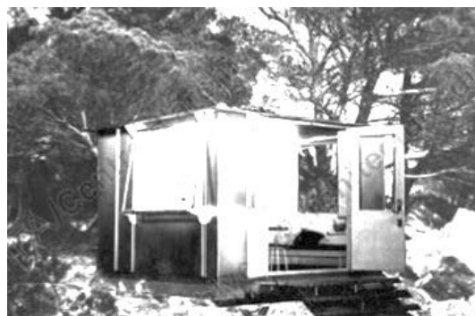
Maison de week-end démontable (en tôles)
