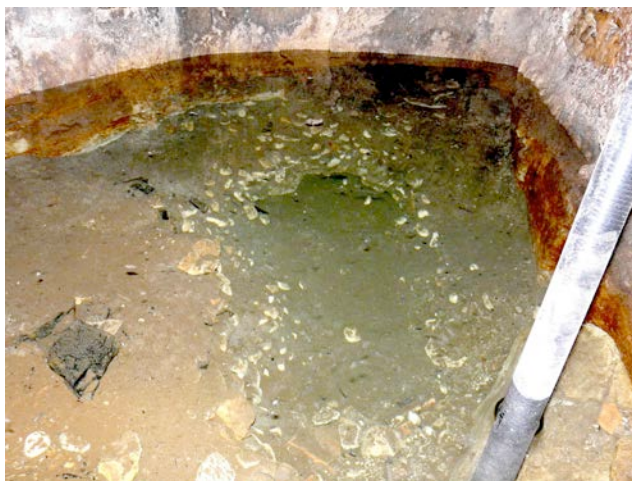
Cavité creusée à la base de l'abside, directement dans la roche massive, et d'où pourrait provenir l'eau douce (à saumâtre) du bassin.
