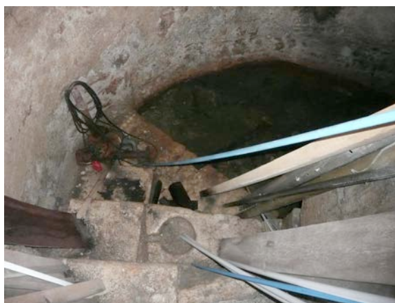
Vue du bassin, creusé dans la roche, et occupant le fond (source, captage ?) de la « Chapelle »
