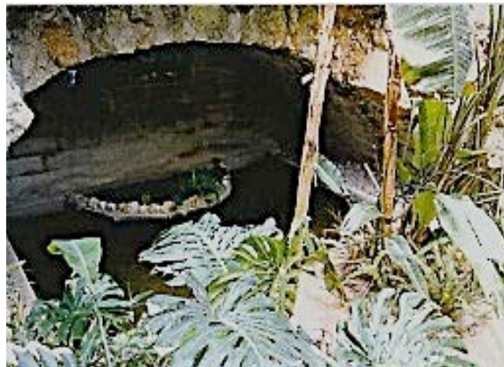
L'un des « culs de fours », à la base du mur occidental, aménagé en bassin
