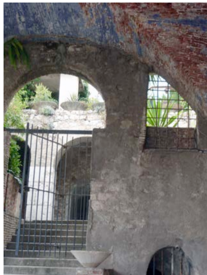
La voûte méridionale, l'entrée et les escaliers vers le jardin terrasse.
