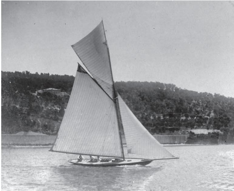
**Fig. 4 :** *Thérèse II*, dessiné et construit par A. Mansueti en 1895 ; il s'agit d'un magnifique cotre à gréement houari, de plus de 11 mètres de long avec une voilure de presque 120 m<sup>2</sup> (document Pagnotta).
