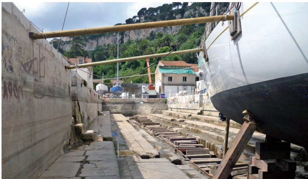
Fig. 6: Une vue partielle du bassin de radoub à sec (avant restauration du bâtiment de l'arsenal) (Collection ASPMV).
