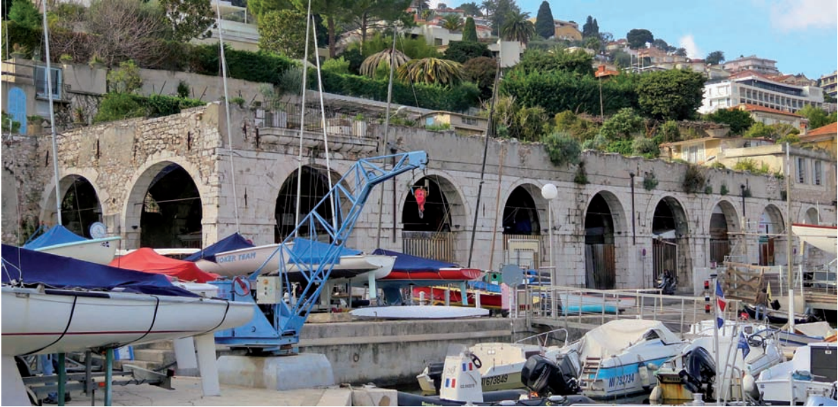
Fig. 3 : Les voûtes de la Darse qui abritent deux chantiers navals et divers ateliers (Collection Masnata Paul). Vaults and workshops of shipyards in la Darse.
