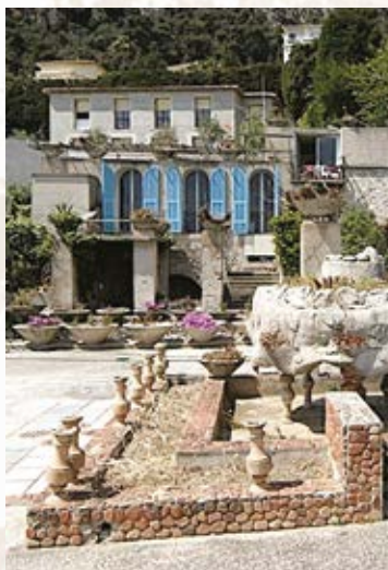
Le siège de l'ASPMV sur la terrace jardin Beaudouin au dessus des voûtes de la Darse
