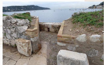
Emplacement de batteries.
