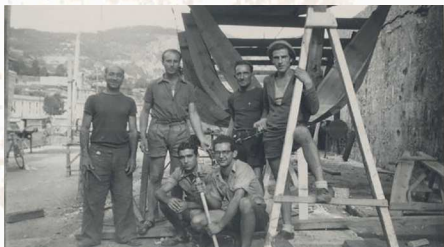
Quelques ouvriers des chantiers Voisin.
