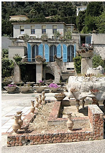
Le siège de l'ASPMV sur la terrasse jardin Beaudouin au dessus des voûtes de la Darse
