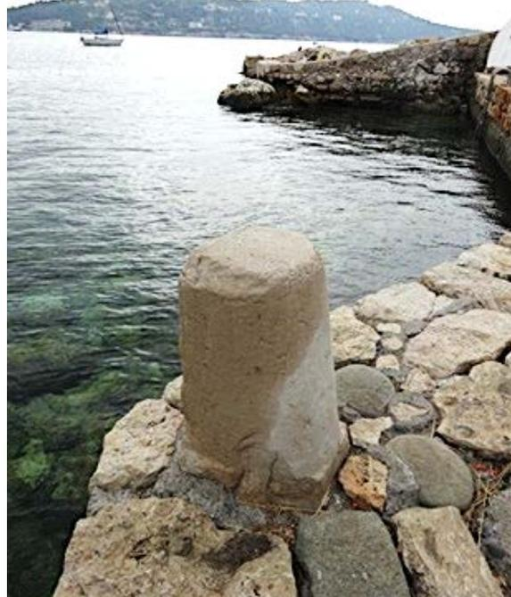
Figure 18 - Une bitte d'amarrage en calcaire massif à l'angle du quai.
