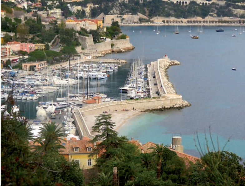
Fig. 3 : Vue de l'actuel môle de protection du bassin de la Darse. On y remarque les aménagements nécessaires à l'installation d'artillerie, y compris de canons pivotants (photo J. Mascle).
