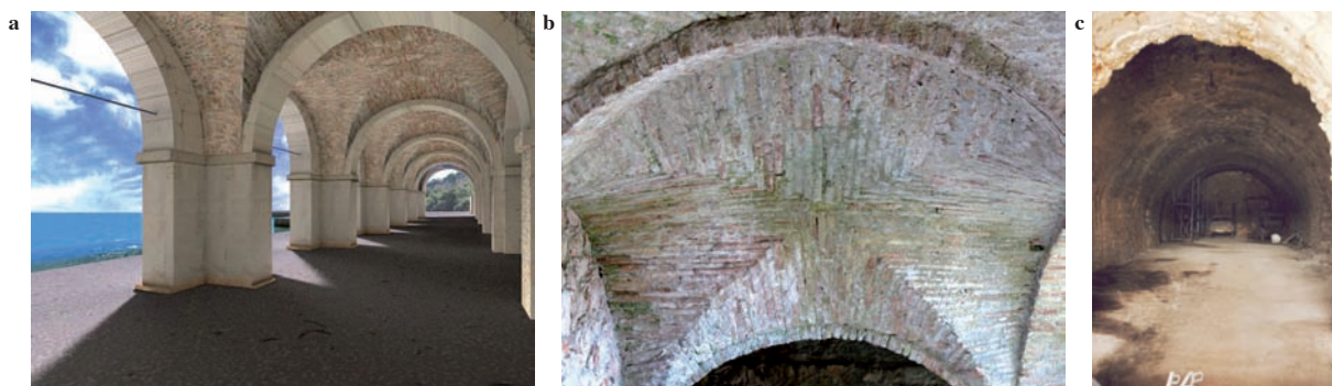
Fig. 7 : a) Une reconstitution de l'enfilade des voûtes (Document ENSA Marseille, 2006) ; b) plafond en briques de l'une des voûtes ; c) l'une des galeries souterraines (photos J.-C. Braconnot).
