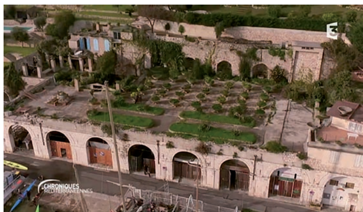
Fig. 6 : Les huit grandes arcades visibles le long de la bordure occidentale du bassin portuaire, construites en parement de huit voûtes en briques, elles-mêmes prolongées par cinq profondes galeries souterraines (photographie par drone extraite de Chroniques Méditerranéennes , France 3).
