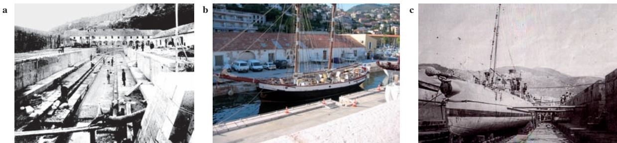
Fig. 27 : Le bassin de radoub : a) à vide vers la fin du XIX e siècle ; b) le Zaca en cours de travaux, c) un contre-torpilleur en cours de carénage au début du XX e siècle (collection J. Masnata).
