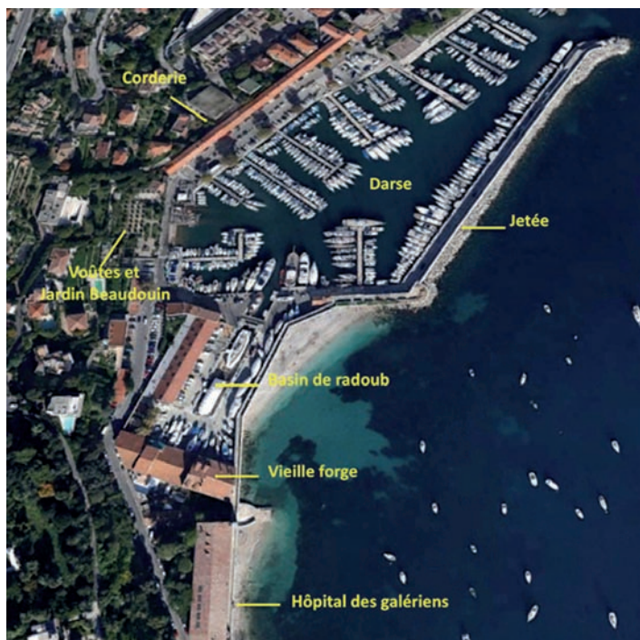
Fig. 1: Vue aérienne (Google Earth) de l'ensemble portuaire de la Darse et de ses différents équipements du XVIII e siècle (en jaune); en bleu vert sont indiquées les localisations de deux éléments, l'un vraisemblablement antérieur (baptistère?), l'autre de création récente, le jardin-terrace Beaudouin. Les chiffres indiquent l'ordre d'apparition des différents constituants de l'arsenal maritime royal.
